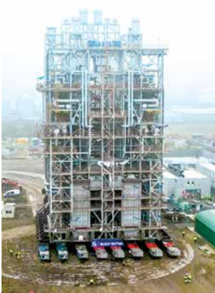
这些裂解炉通过自推进式模块化运输车运至施工现场
